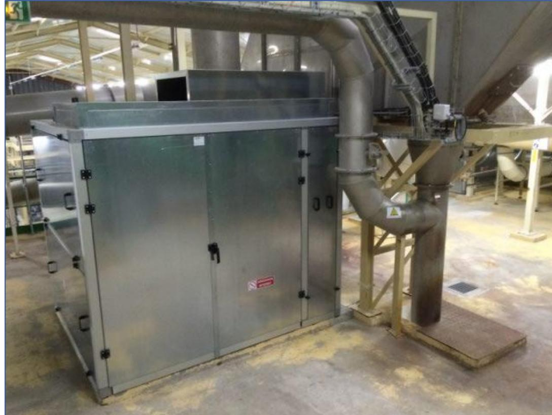
Exemple de caisson acoustique pour compresseur.
