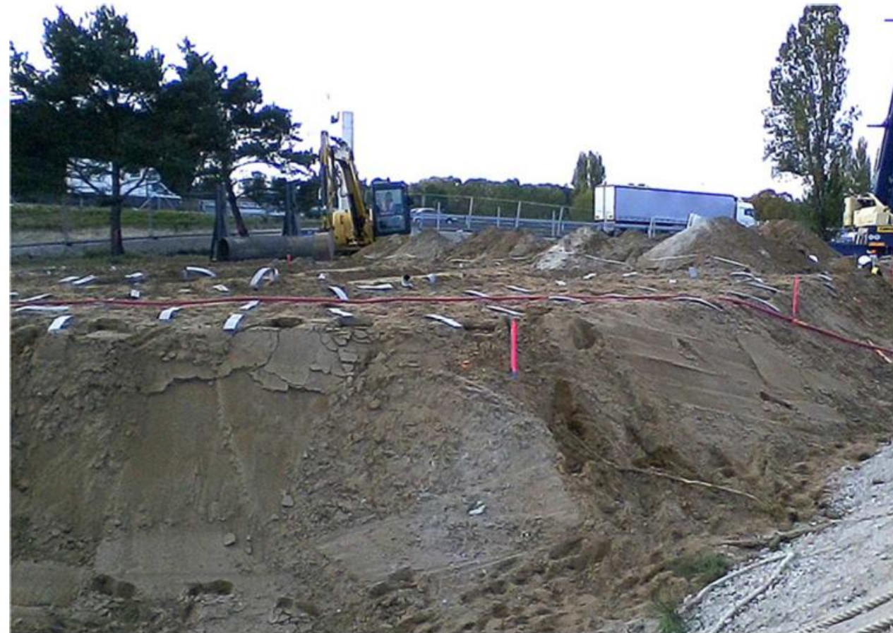
Exemple de chantier comparable de Gironde
